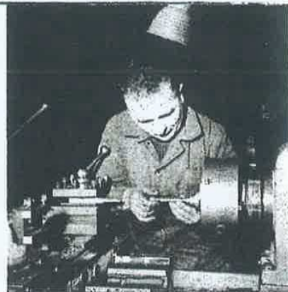
M. Rigaudeau - 200 HN - Contrôle d'un alésage avec tampon.
