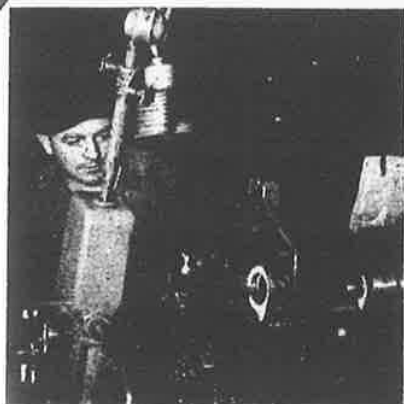
M. Lerouge - 250 HN banc rompu - Alésage d'un bras support en lu- nette et mors doux.
