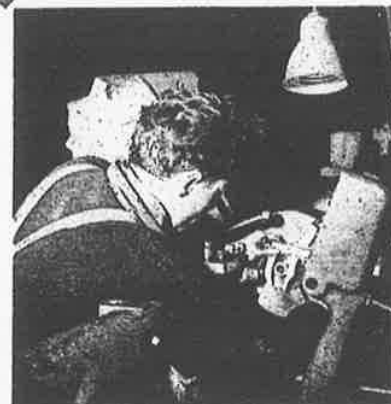
M. Ganachau - 200 HN - Prise d'une cote à l'aide d'un pied à coulisse.
