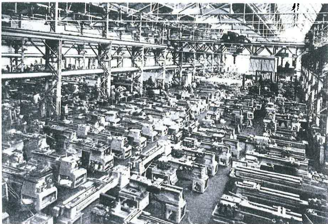
Vue de la Travée E Service du Montage
